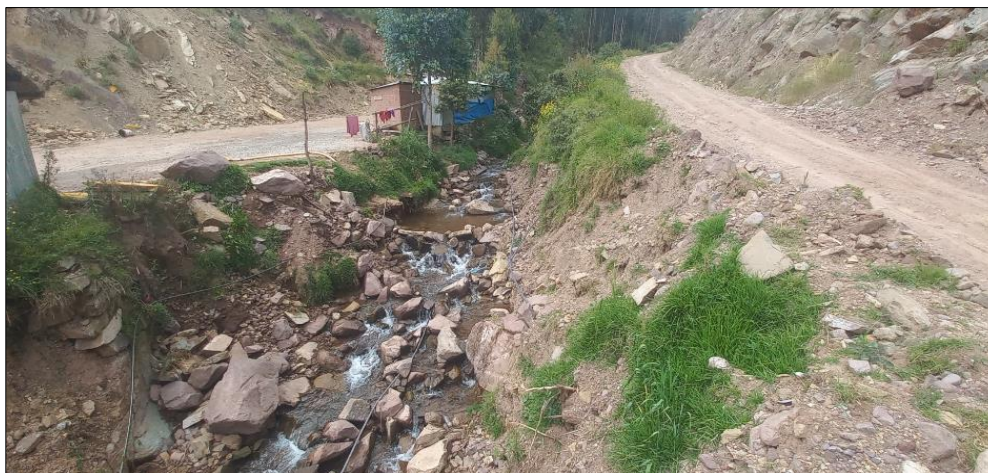
FIGURA N°01: TRAMO CRÍTICO EN LA QUEBRADA CHUSPIYOC, DISTRITO DE POROY, PROVINCIA DE CUSCO, SE APRECIA EL CAUCE COLMATADO.
